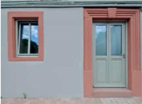
◆ Das massive Erdgeschoss wird durch ein profiliertes Gurtgesims optisch vom Obergeschoss getrennt. Die Öffnungen werden hier von Sandsteingewänden umrahmt. Die Haustür aus Holz ist nach historischem Vorbild mit kassettenartigen Füllungen und zwei rechteckigen Fenstern im Türblatt ausgeführt. Durch die einheitliche Farbgestaltung der Öffnungen und deren Umrahmungen ergibt sich ein stimmiges Gesamtbild.
