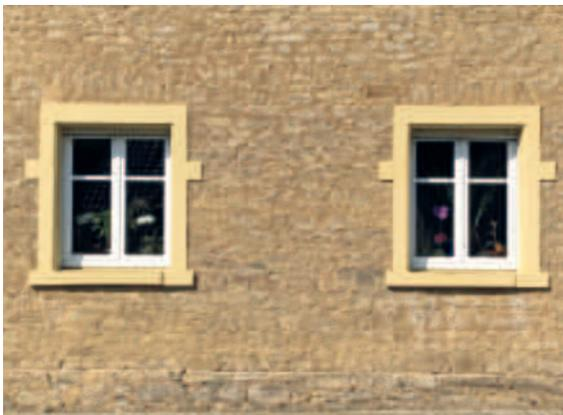
◆ Der Natursteinbau zeigt seine Bauweise unverkleidet und prägt mit seinem unregelmäßigen Schichtenmauerwerk aus Muschelkalk das Ortsbild. Die Steine werden hier mit maximal 3 Zentimetern breiten Fugen in Mörtel gesetzt. Aufgrund der unregelmäßigen Anordnung der Steine sollte in einem wiederkehrenden Abstand eine durchgehende Längsfuge den erforderlichen Ausgleich schaffen.
