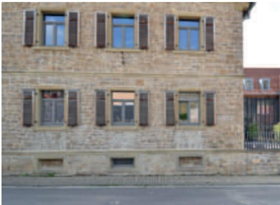
◆ Ein Ausschnitt der Fassade zeigt das unregelmäßige Bruchsteinmauerwerk aus Muschelkalk im Detail. Die einzelnen Geschosse werden durch Gurtgesimse unterteilt. Die stehend rechteckigen Fensterformate reihen sich in diese Unterteilung in senkrechten und waagerechten Achsen ein. Zusammen mit der Wahl eines einheitlichen Fensterformats ergibt sich ein ruhiges und harmonisches Fassadenbild.
