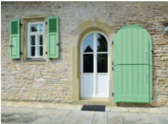
◆ Luft als Wärmedämmung – im Erdgeschoss befinden sich Kastenfenster aus Eichenholz. Dabei besteht das Fenster aus zwei Glasscheiben, die im Abstand von etwa 10 Zentimetern hintereinander eingebaut sind. Der Luftraum dient der Wärmedämmung.
