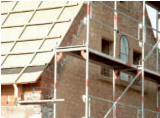
◆ Durch das nachträgliche Herstellen eines Kniestocks mit einer Höhe von 30 Zentimetern wird der Raum unter dem steilen Satteldach erhöht und kann damit zum Wohnen gut genutzt werden.
