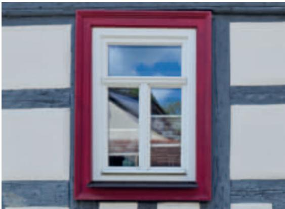
◆ In diesem Beispiel werden Nachbildungen von sogenannten Galgenfenstern eingebaut: Das sind einflügelige Fenster aus Holz mit senkrechten Sprossen, aufgesetzten Scheinschlagleisten und einem Oberlicht. Umfasst werden diese durch sogenannte Fensterbekleidungen aus Holz. Diese sind fachgerecht aufgearbeitet und farblich an das Gurtgesims angepasst.
