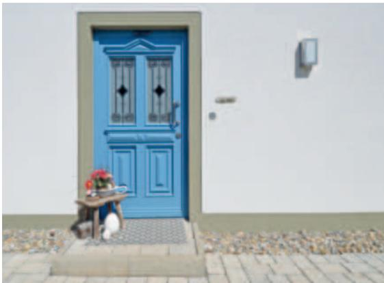
◆ Die neue Haustür wird aus heimischem Kiefernholz gefertigt. Typisch sind die kassettenartigen Aufdoppelungen und die Fenster im Türblatt. Diese sind als Rechtecke im oberen Bereich der Tür angeordnet und sorgen im Flur für ausreichende Belichtung.
