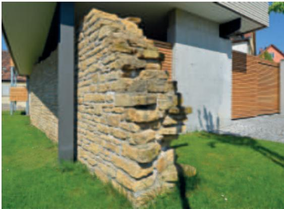
◆ Das Gebäude wird bis auf die Dorfmauer abgerissen. Da der Untergrund nicht ausreichend tragfähig ist, wird die Dorfmauer sorgfältig abgetragen, eine Betonplatte erstellt und die Mauer an derselben Stelle wieder aufgebaut.
