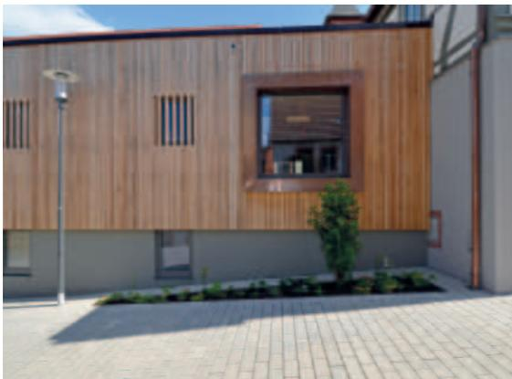
◆ Alt trifft Neu – nicht nur innen sind Alt- und Neubau verbunden. Auch im Außenbereich wird beispielsweise durch die einheitliche Materialwahl von Blenden und Regenrinnen aus Kupfer eine Verbindung zwischen den Baukörpern geschaffen. Typisch fränkisch wird der Anbau mit einer senkrechten Bretterschalung aus Lärchenholz ausgeführt – Wasser kann so gut ablaufen und das Holz schnell wieder abtrocknen. Im Laufe der Zeit wird die Holzschalung eine gräuliche natürliche Patina entwickeln.
