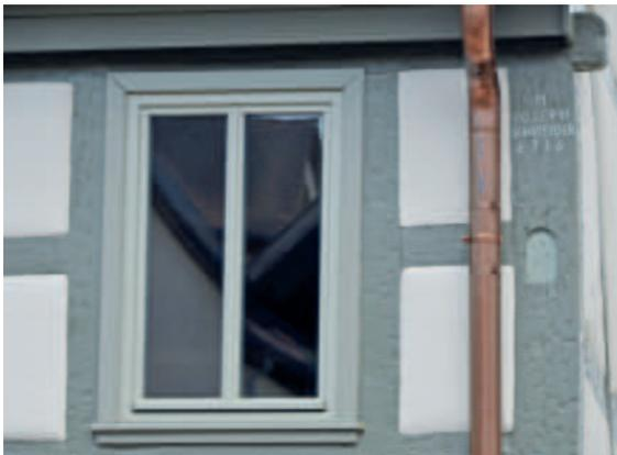
◆ Die Holzfenster sind mit einer Mittelsprosse und Scheinschlagleiste versehen. Durch sogenannte Fensterbekleidungen sind diese in die bestehende Fachwerkkonstruktion eingepasst. Regenrinnen beziehungsweise Fallrohre aus Kupfer bilden auf dem Fachwerk einen farblichen Akzent. Auf dem Eckpfosten des Fachwerks ist die Inschrift aus dem Baujahr 1716 wieder gut sichtbar.
