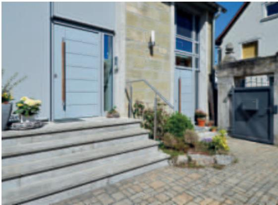
◆ Durch den geschickten Umbau entstehen zwei getrennte Wohneinheiten in der ehemaligen Scheune. Die neue Eingangstreppe wurde als Betonunterkonstruktion mit rechteckigen Natursteinplattenverkleidungen hergestellt. Das Treppengeländer zeigt sich schlicht und modern aus Edelstahl.
