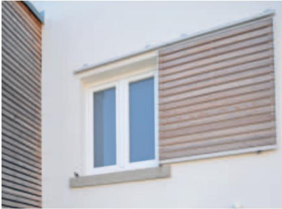
◆ Die Schiebeläden aus Holz setzen einen modernen Akzent auf der schlichten Putzfassade. In einen Rahmen gefasst laufen sie innerhalb eines Schienensystems oberhalb des Fensters. Es handelt sich um eine horizontale Verbretterung aus Lärchenholz. Eine moderne Interpretation unserer traditionellen Fensterläden.
