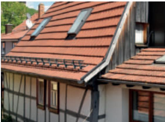
◆ Die regionaltypischen Aufschieblinge erkennt man als „leichten Knick in der Dachfläche“ im Bereich der Traufe. Bei Gebäuden mit einer Holzbalkendecke und einer steilen Dachneigung werden keilförmige Hölzer angebracht, um das Regenwasser sachte abzuleiten.
