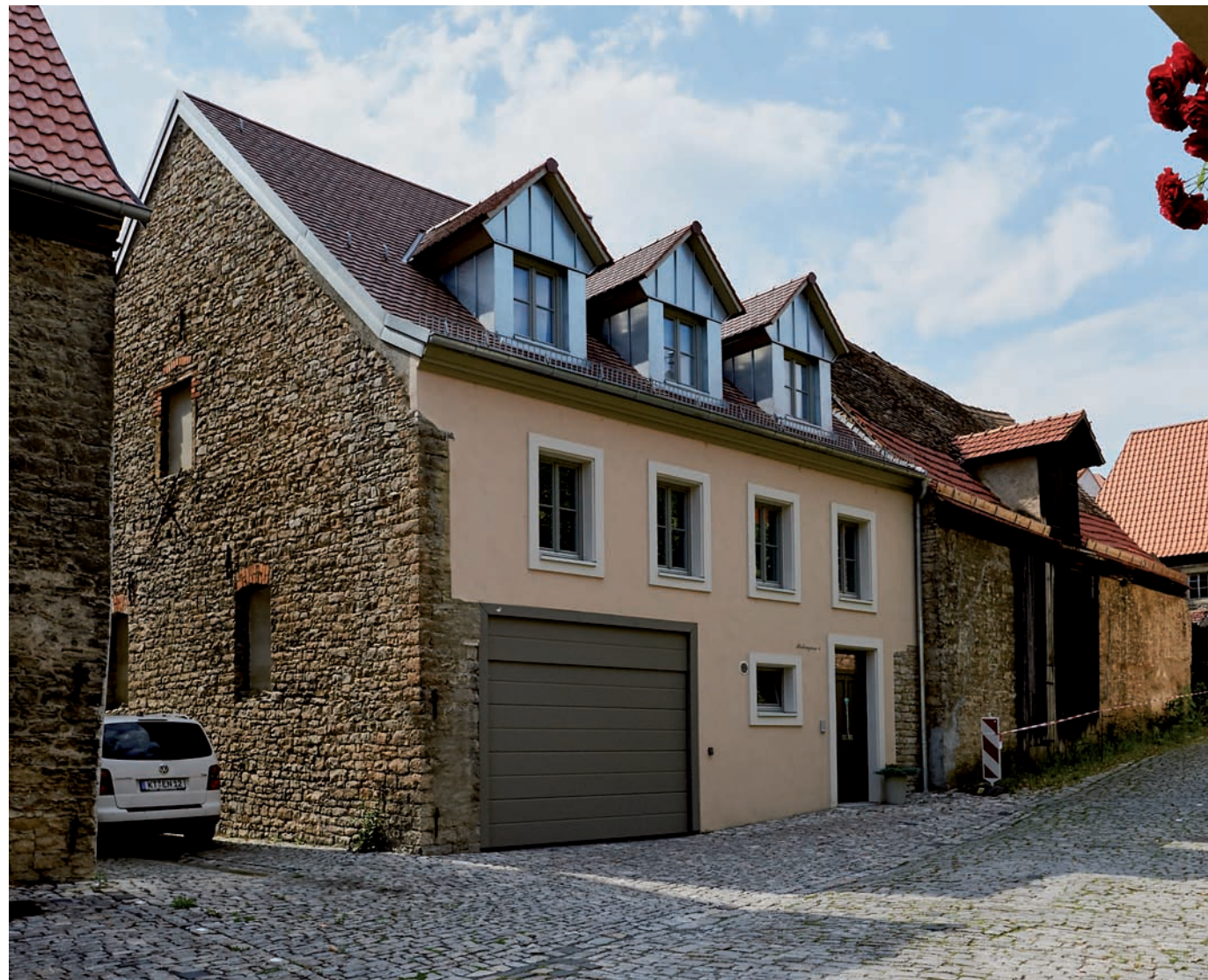
Glatte, homogene und glänzende Oberflächen sind an alter Architektur kaum zu finden. Modernes Bauen im
