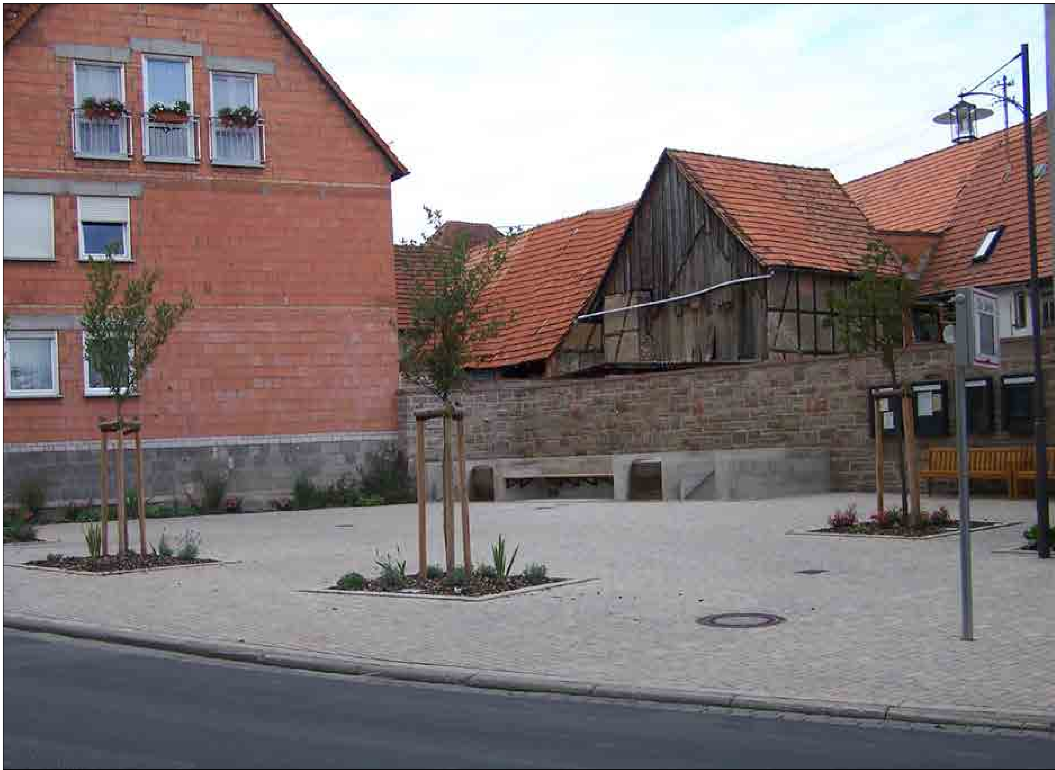
Neuer Dorfplatz an der Hauptstraße nach der Fertigstellung
