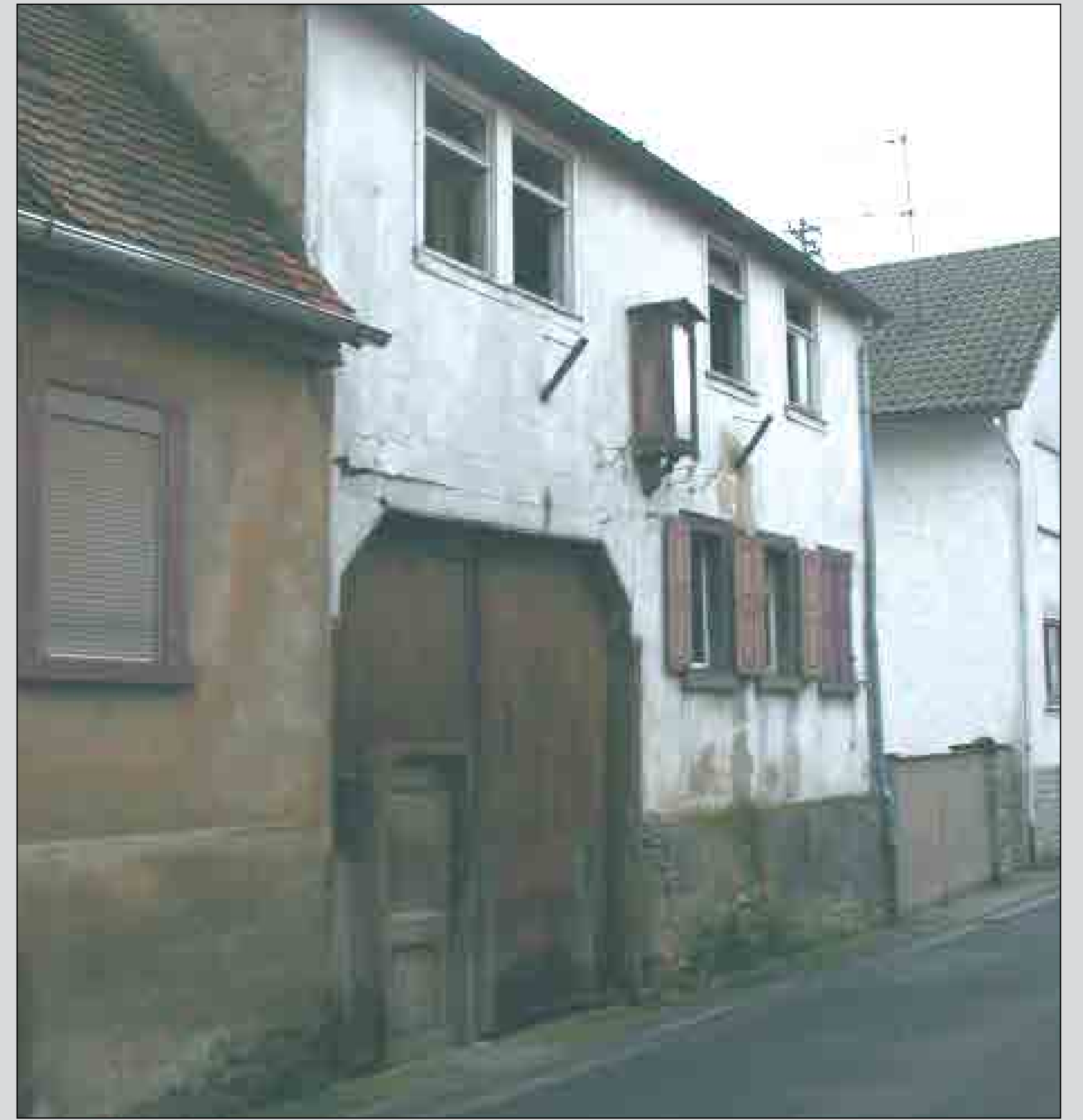
Leerstand Schloßstraße Nr. 6 vor dem Abbruch
