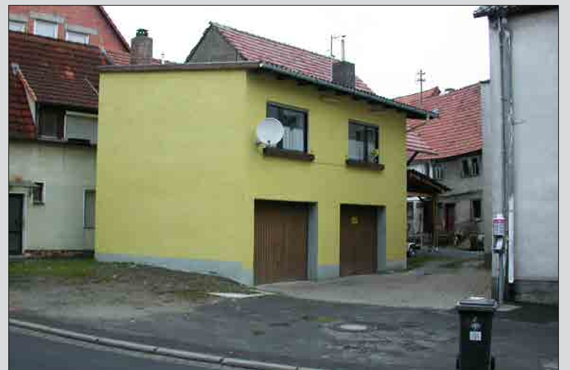
Abzubrechendes Gebäude auf Flst.Nr. 136/3
