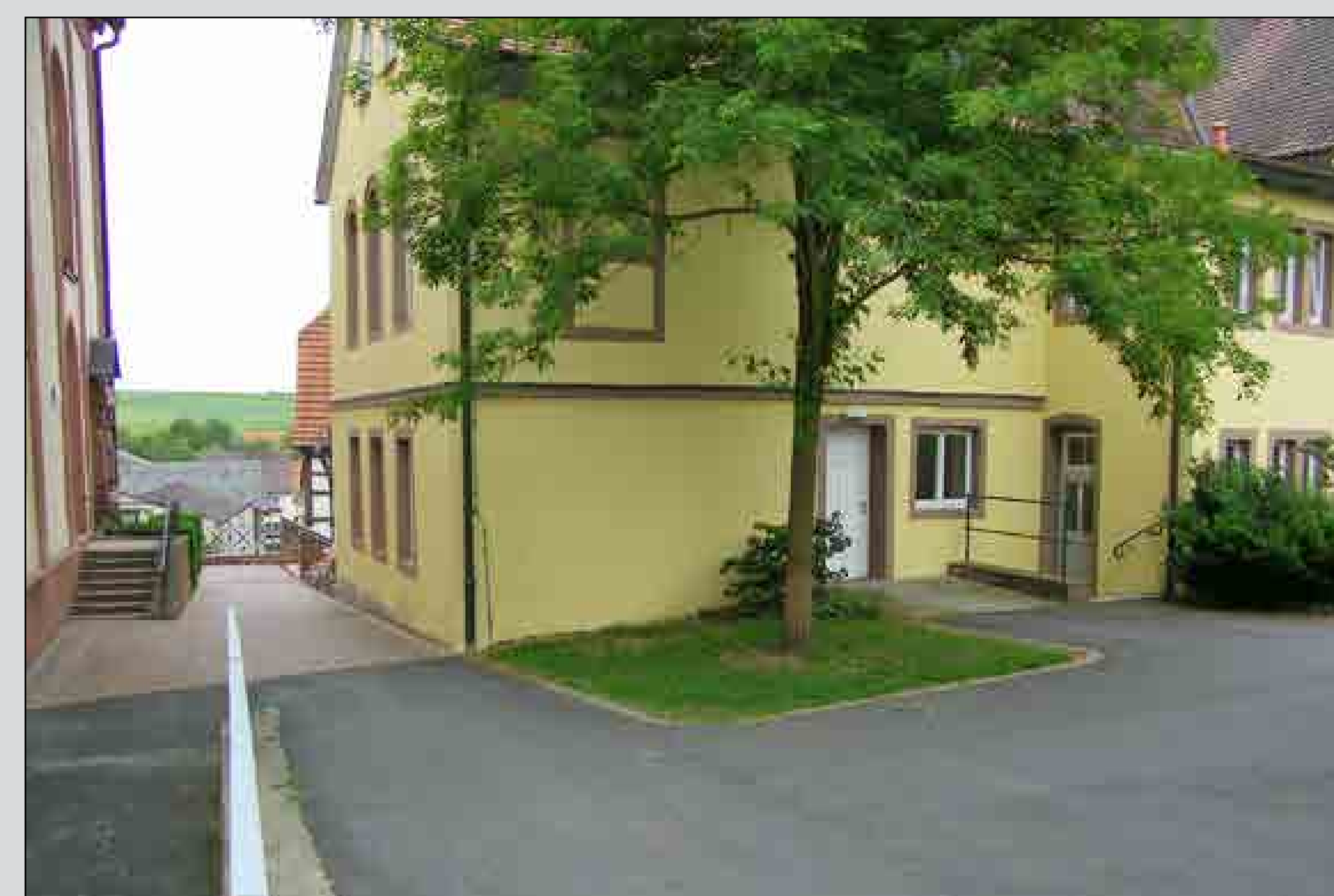
Rückwärtiger Bereich und barrierefreier Zugang zum Rathaus nach Fertigstellung der Maßnahme
