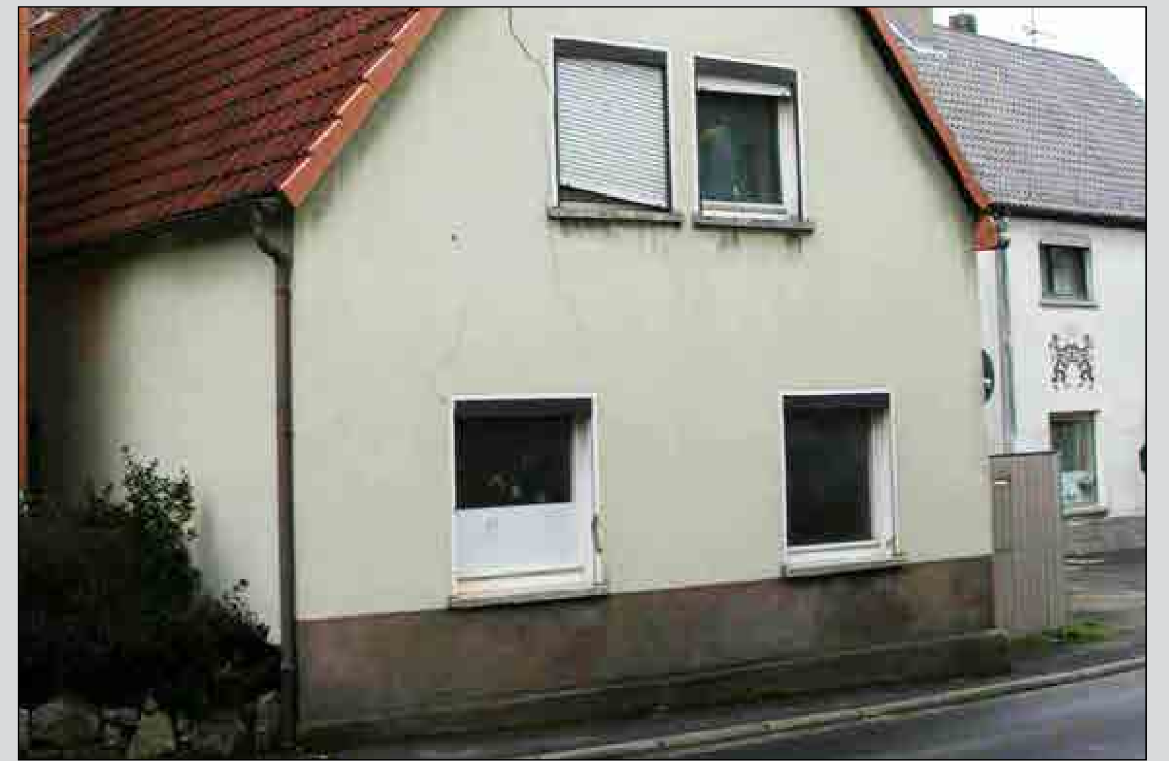
Abzubrechendes Gebäude auf Flst.Nr. 137
