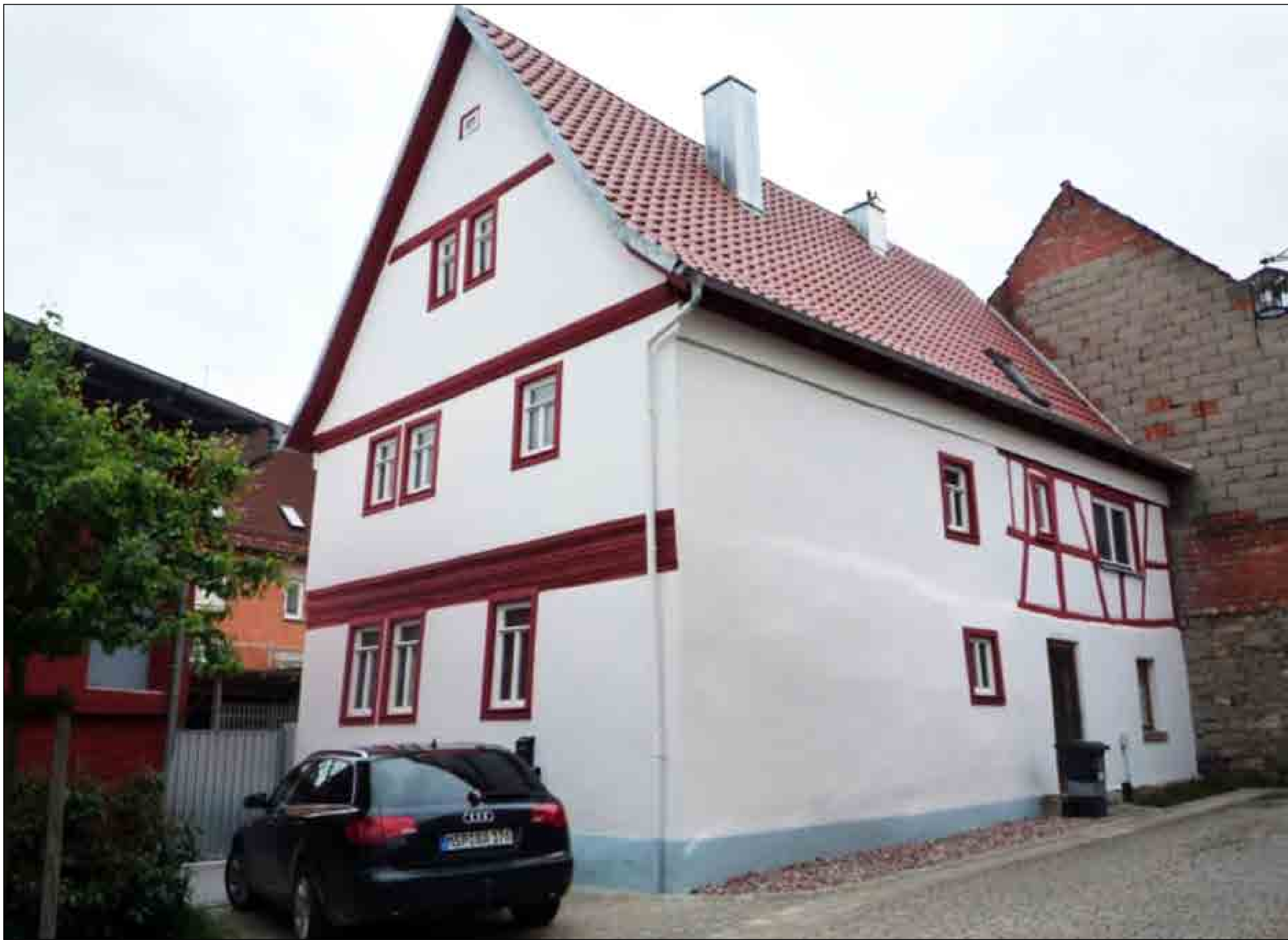
Fassadenneugestaltung Hauptstraße 18 und 20
