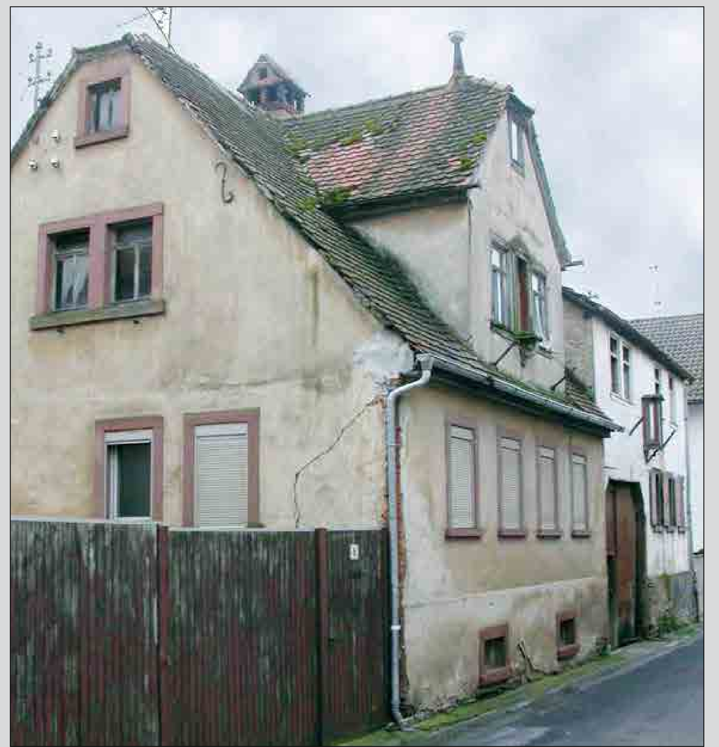
Leerstand Schloßstraße Nr. 8 vor dem Abbruch
