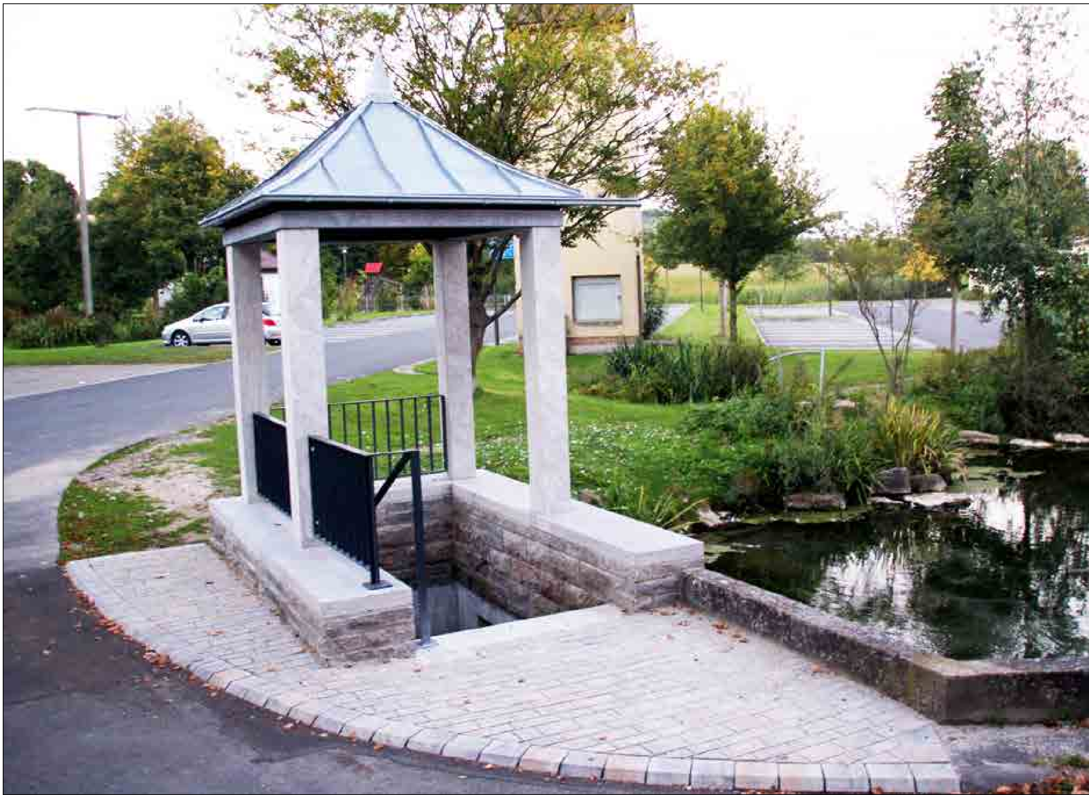
Sanierung des Brunnens am Gäulsbach
