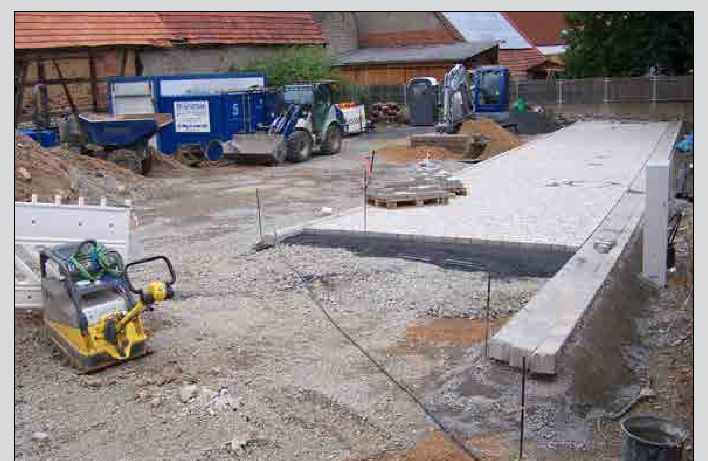
Ausführung Stichweg Schloßstraße
