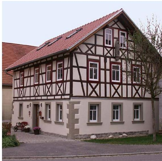
◆ Links: Sanierungsbedürftiges Wohnhaus im Ortskern. Rechts: Im Zuge einer umfassenden Sanierung wurde das Wohnhaus auch gestalterisch erheblich aufgewertet. Das Dach erhielt eine neue Eindeckung mit naturroten Tonziegeln. Bei der Neugestaltung der Außenfassade wurde eine Naturstein- und Fachwerkrestaurierung durchgeführt. Die verputzte Fassade erhielt einen neuen Farbton.
